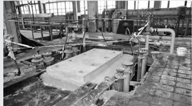
На участке аммиачно-хлорной установки (АХУ) цеха № 4 продолжается капитальный ремонт аммиачного компрессора ДАО-550-03.
